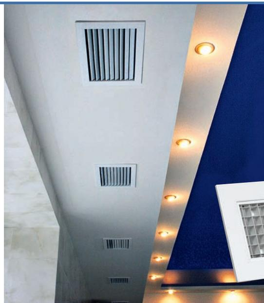
➔ В спортивном зале коттеджа настенные вентиляционные решётки установили на подшивном потолке в ряд вдоль оконного остекления
