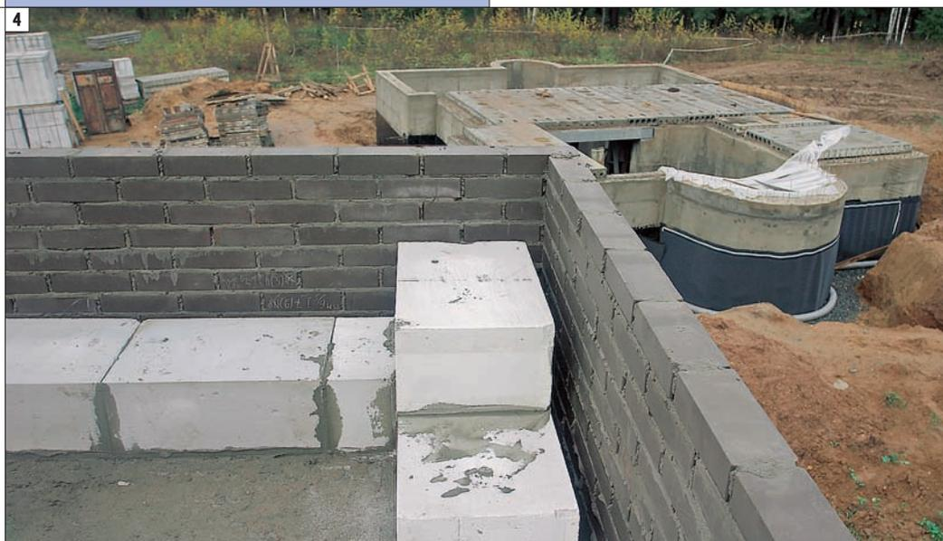
пенобетон. Приготовленную такими способами массу заливают в формы большого размера, а когда она застынет, распиливают на блоки.
