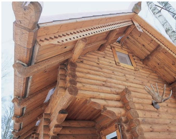
↑ Консоли-курицы на самцовой кровле. Они поддерживают поток, который не только обеспечивает сток воды, но и является нижней опорой кровельного теса
